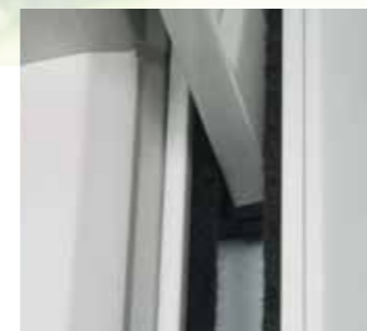
Aluminium-Laufschienen mit eingezogenen Bürsten für geräuscharmen Lauf
