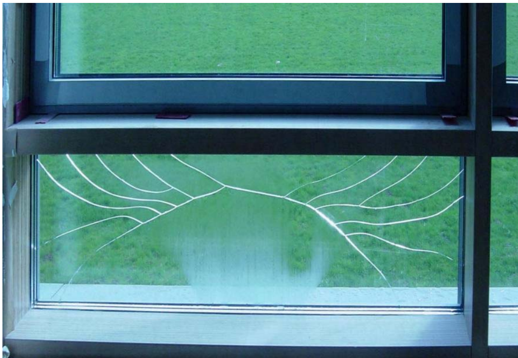
Bild 1 Glasbruch bei Dreifach-Isolierglas verursacht durch Luftdruck- und Temperaturänderungen (Quelle IP).
