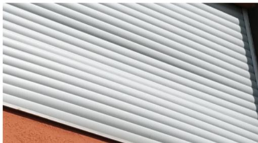
Durch die neue Rezeptur verringert sich die Erwärmung des Rollladenbehangs und somit auch die Gefahr einer thermischen Verformung wie in den abgebildeten Beispielen.
